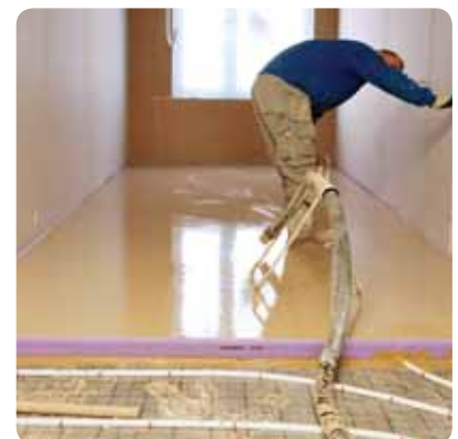
Måling av støpehøyden.
