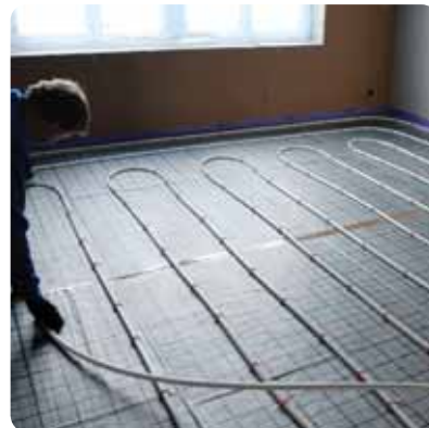
Rørsløfene får et jevnt og fint leggemønster på trinnlydplatene.
