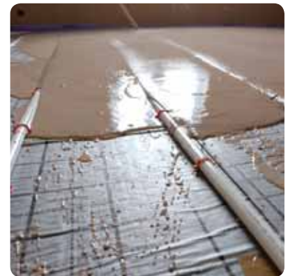
Perfekte flyteeenskaper. Massen tetter fullstendig rundt røret.
