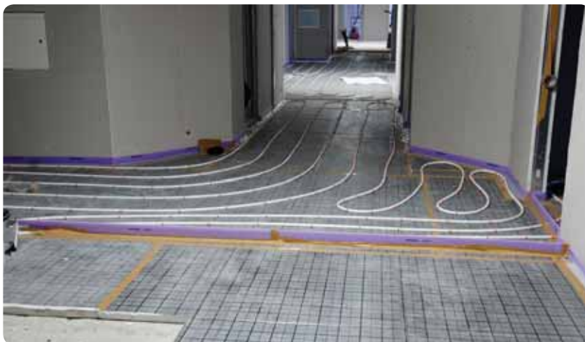
Fleksibiliteten i fremdriften tillater en oppdeling av leggemønsteret. Støpingen kan starte i bakgrunnen mens monteringen av lydtrinnplatene fortsetter i forgrunnen.
