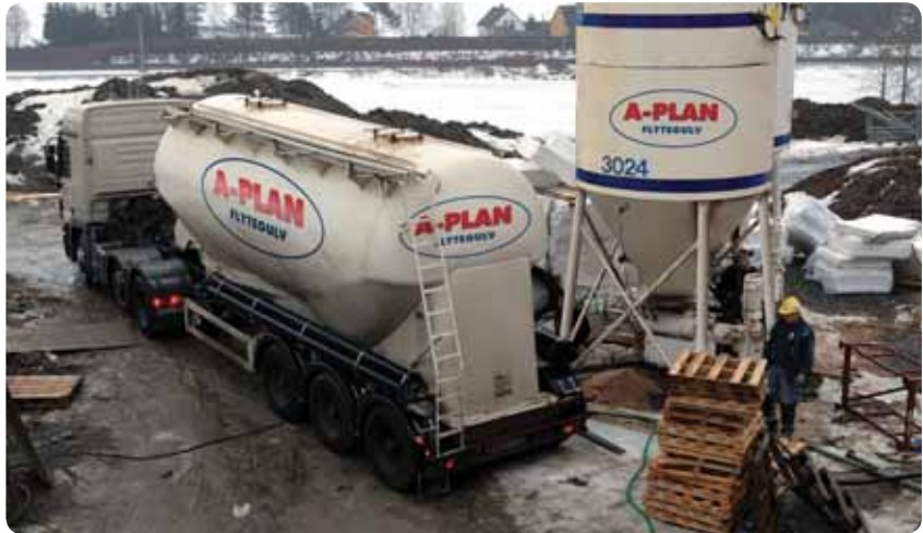
Tørrmørtel fylles fra tankbil til silo. Vann blandes i mikser under silo og pumpes inn i bygget.
