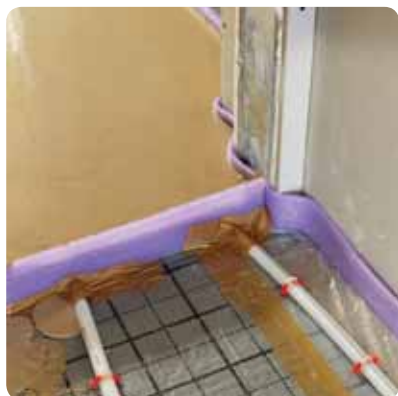
Rommene deles av med kantisolering m/plastvinkel.
