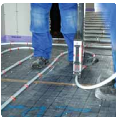
Klamring av rørene med clips for hver 30 cm.
