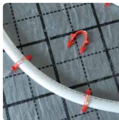
Rørklips med mothaker festes i den armerte folien.
