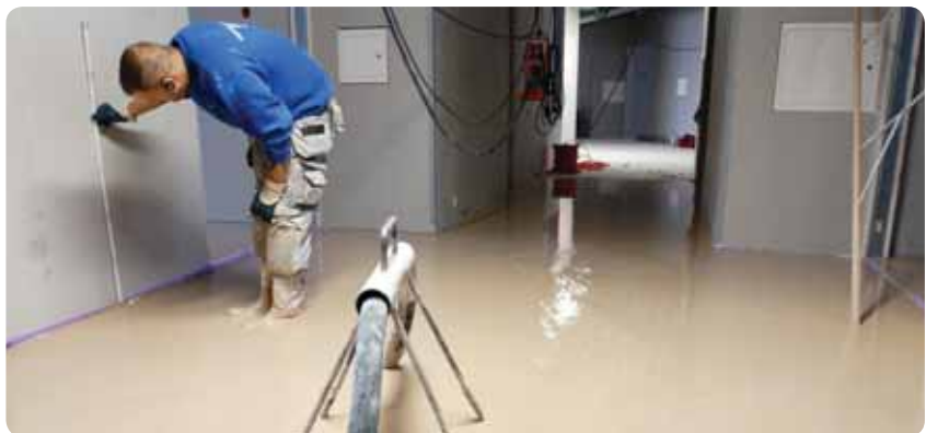
Rommene fylles fort opp til en absolutt horisontal flate. Overdekning til gulvarmerørene skal være minst 20 mm. Normal støpehøyde er 45 - 50 mm. Total byggehøyde inkl. trinnydplate (30 mm) blir 75-80 mm.
